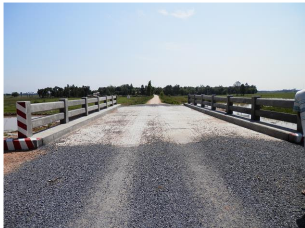
写真2：念願の橋が完成
