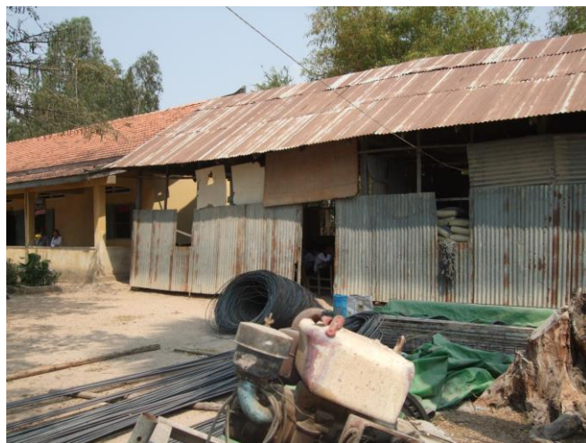
写真：新校舎が完成すればトタン屋根の旧校舎は取り壊される。左奥の校舎はC E A F が 1993 年建設。
