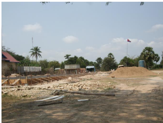
写真：バンティチャクライ中学で新校舎の土台作りの工事が始まった。
